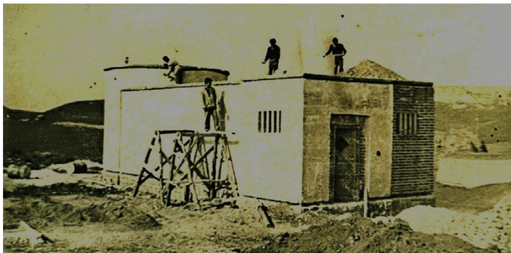
Обсерваторията в строеж, 15 юни 1962 г. 2)
